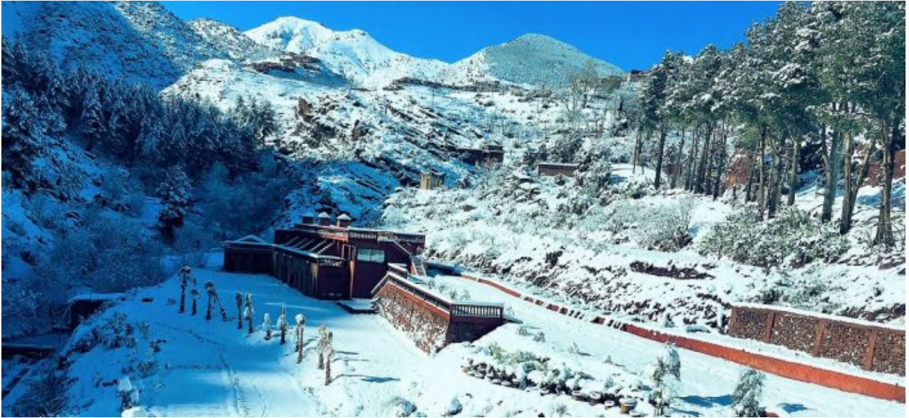
Figure 1.15 Infrastructure routière de la station de ski de l'Oukaimeden
