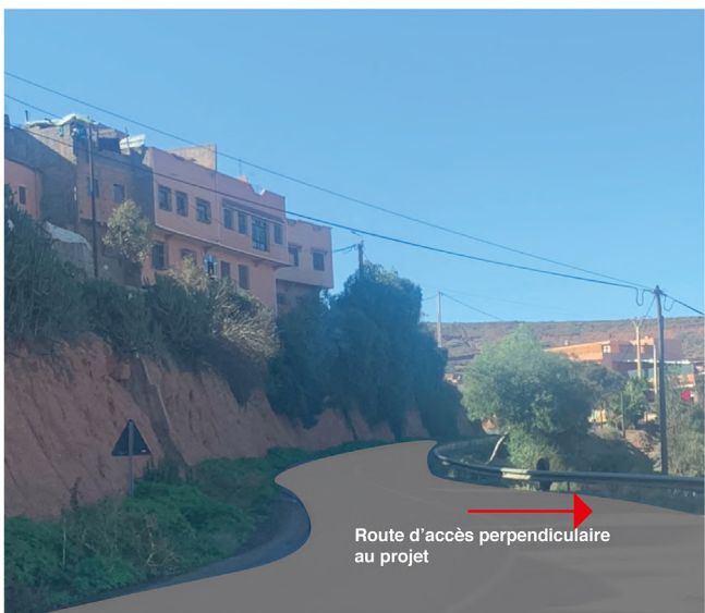
Habitations en pierre et en terre cuite sur trois niveaux
