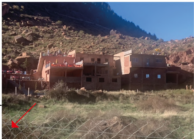
Habitations en pierre et en terre cuite sur trois niveaux
