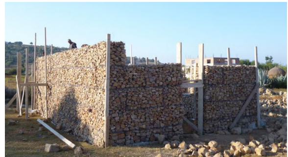
Figure 3.75 Technique de mur en pierre confinée
