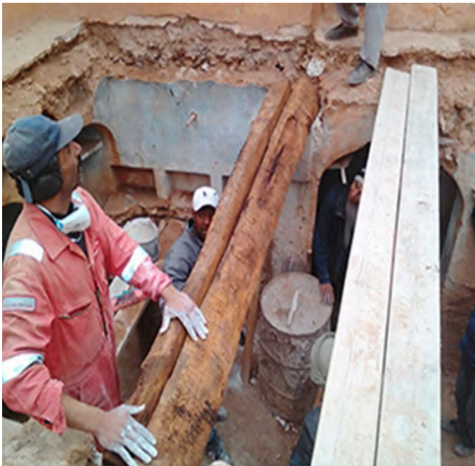
Figure 2.7 Techniques de construction au M'zab
