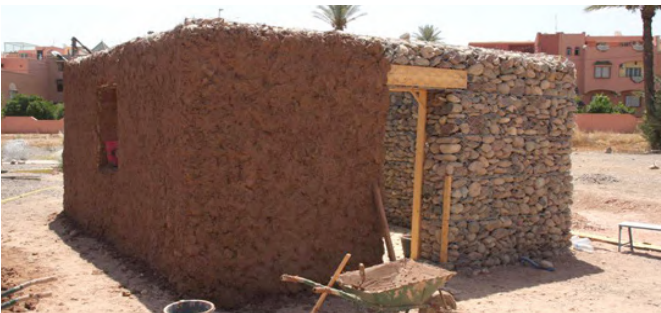
Figure 3.74 Technique de mur en pierre confinée (MPC)
