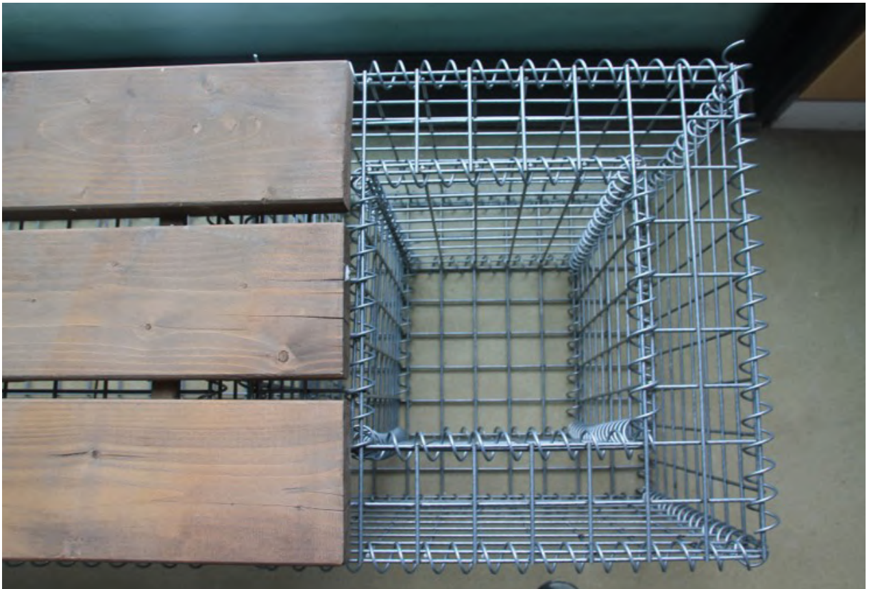
Figure 4.73 Détail du banc an gabion
